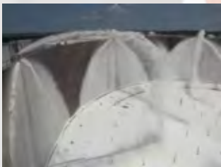
Williams Ambush System; Belucht blusschuimsysteem voor zowel rim seal als full surface branden
